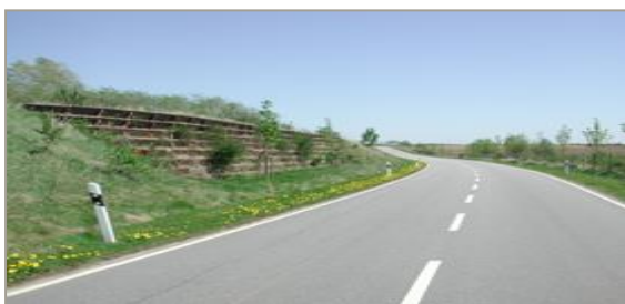
Bepflanzte Lärmschutzwände neben der Kreisstraße MSE 68 Planted noise protection walls next to the district road MSE 68
